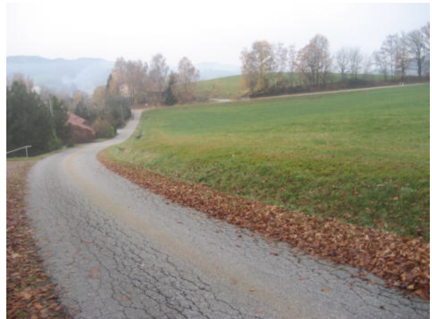
Abb. 5: Blick vom südlichen Weg von Osten auf den westlichen Bereich
